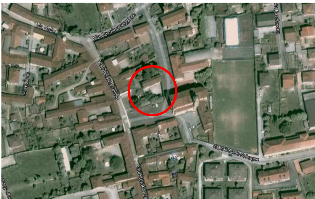
Figura 1 - Foto aerea con indicazione dell'immobile oggetto di Variante (fonte: Google Earth)
