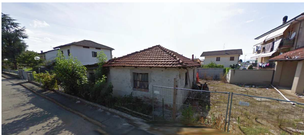
Figura 17 - Foto del basso fabbricato e area di pertinenza in forte stato di degrado indicati con la lettera D nella Figura 18
