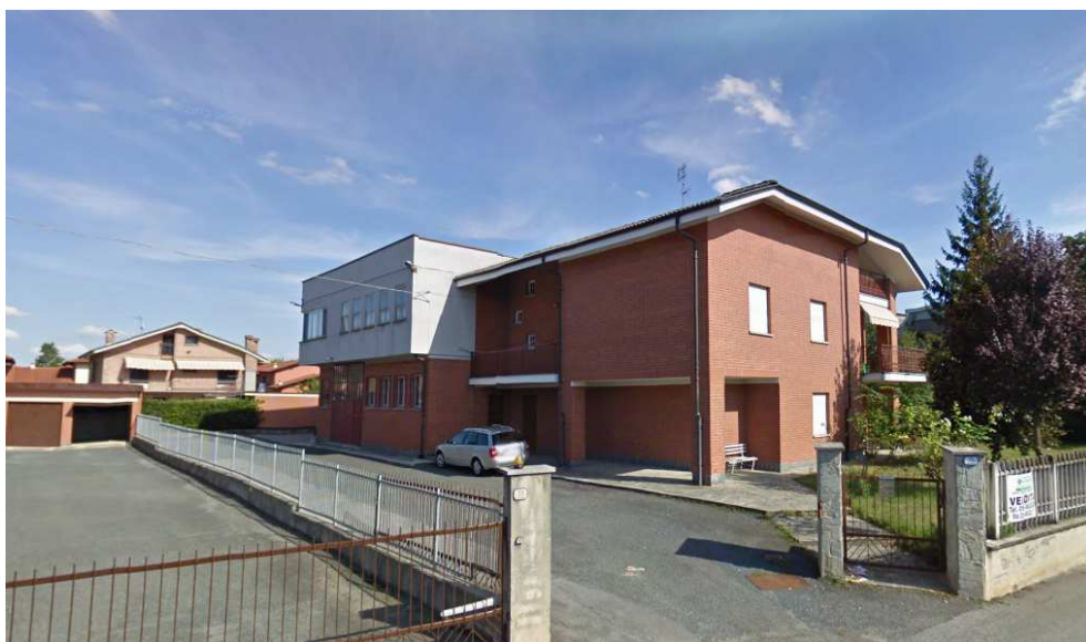
Figura 16 - Foto del fabbricato produttivo ed annessa unità abitativa indicati con la lettera C nella Figura 18
