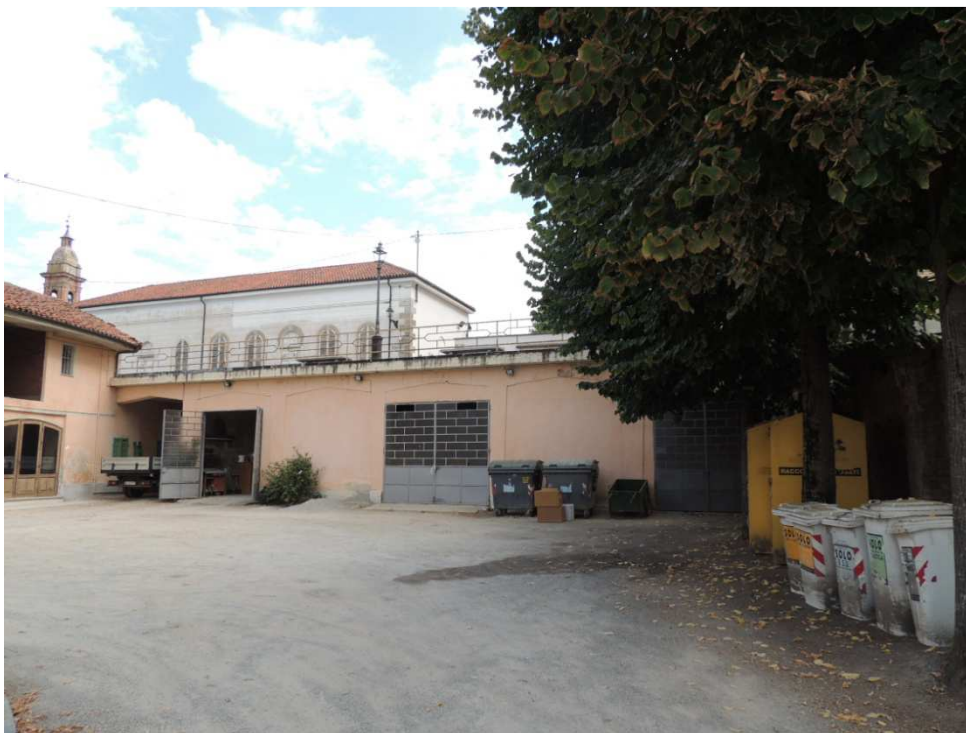
Figura 4 - Fabbricato accessorio - prospetto su cortile interno
