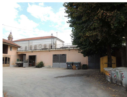
Foto 2 - Fabbricato accessorio - prospetto su cortile interno
